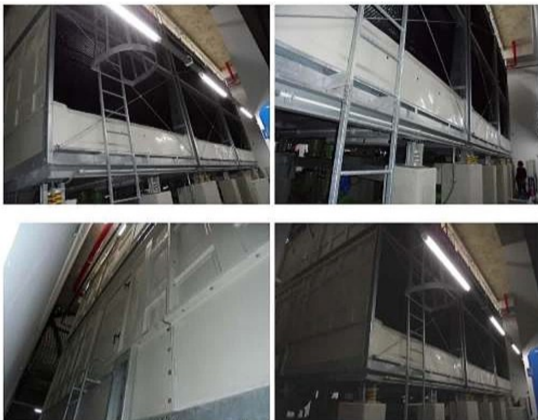
ภาพที่ 3-4 ระบบหล่อเย็นของโครงการ Cooling Tower
