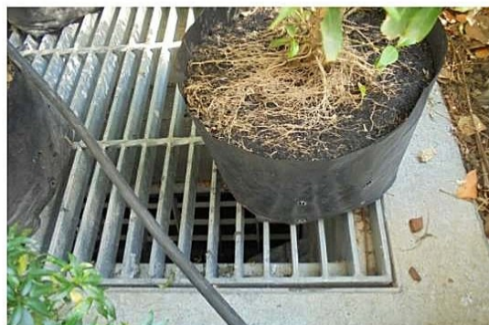
ภาพที่ 3-19 ป่อตรวจคุณภาพน้ำฝาทะแกรงเหล็ก และภายในมีตะแกรงดักขยะ
