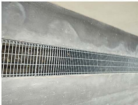
ภาพที่ 3-18 แนวท่อระบายน้ำริมรั้วรอบโครงการ ไม่มีขยะอุดตัน
